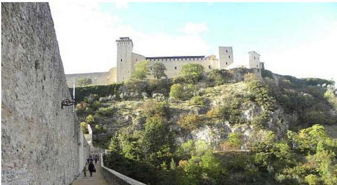
L'attraversamento del Ponte dal Giro della Rocca al Fortilizio dei Mulini.
