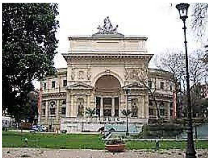
Roma, Casa dell'Architettura, in concessione del Comune di Roma come sede dell'Ordine degli Architetti di Roma
