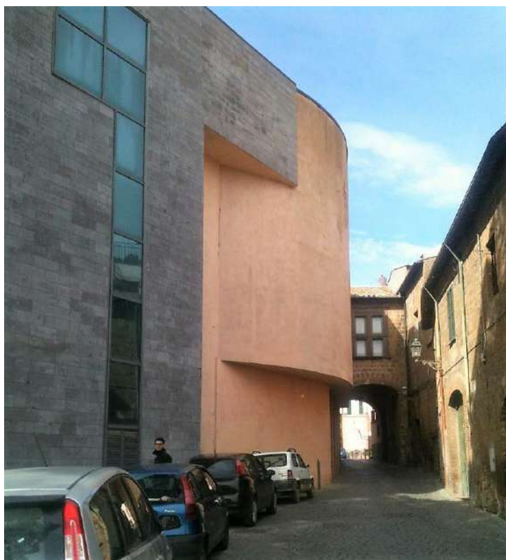
Tuscania (VT), Nuovo Teatro Comunale, architetti Maurice Kanah e Marco Porta
