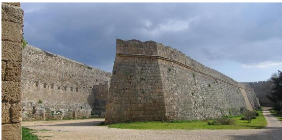
Doppi bastioni difensivi, raggiungibili attraverso camminamenti sotterranei.
